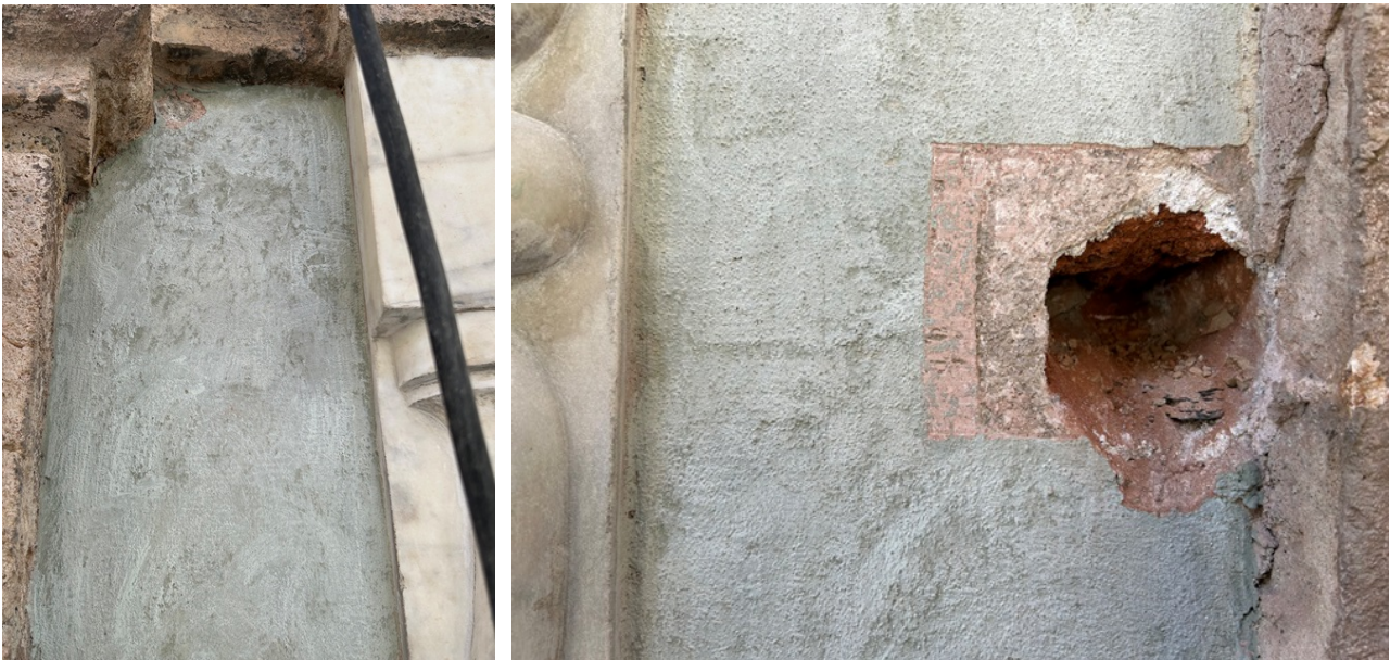
Foto 1 e 2 – Piano ammezzato nel basamento: i campioni mostrano uno strato inferiore di colorazione rosa/ocra a probabile imitazione del colore della Pietra di Finale che costituisce il basamento
