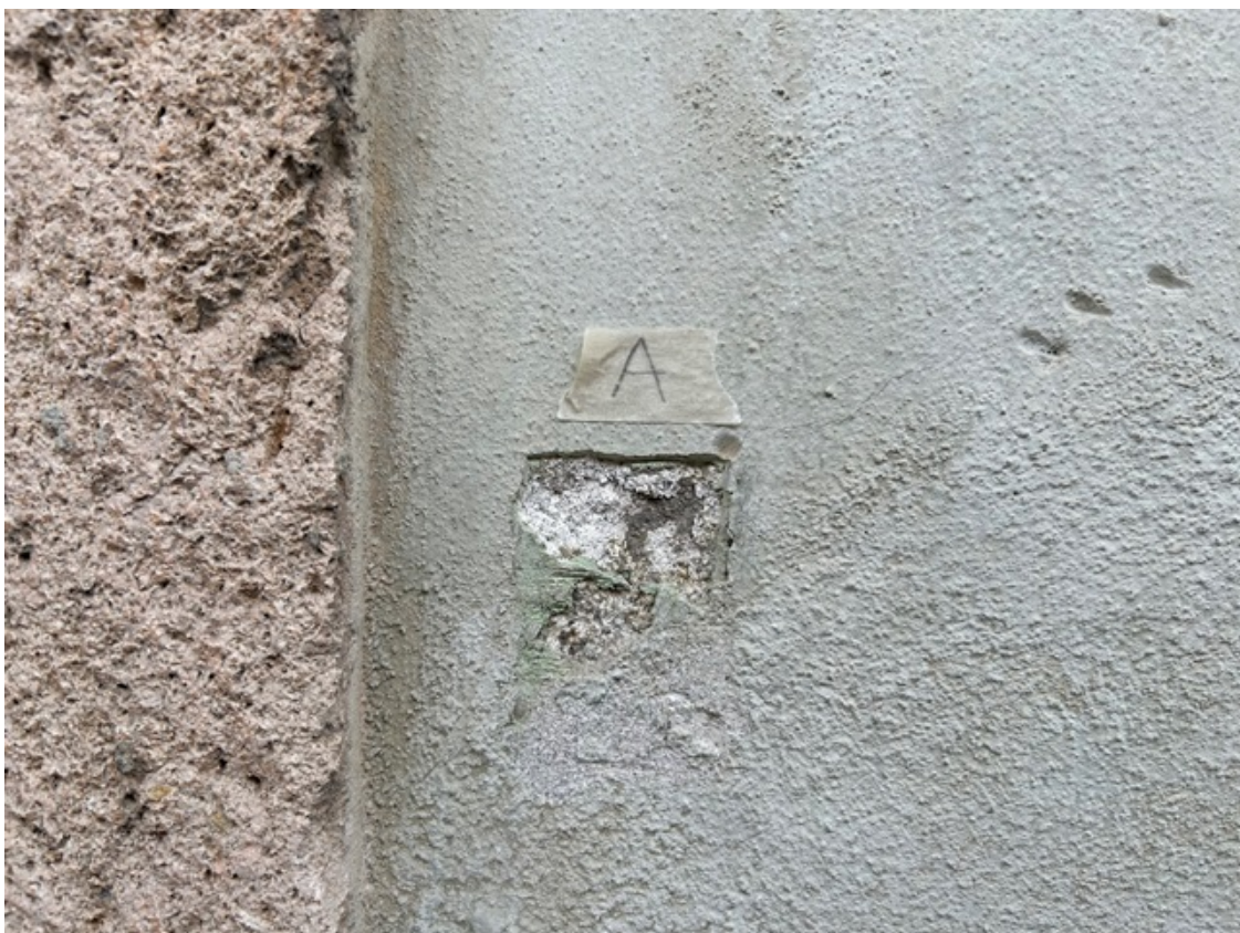
Foto 3 – Piano primo nobile: si riscontrano tre livelli di finitura nel fondo a intonaco liscio compreso tra le paraste in Pietra di Finale: lo strato immediatamente inferiore indica la colorazione verde patina (potrebbe risalire alle modifiche settecentesche), quella di fondo lascia supporre un'originale colorazione rosa/ocra ad imitazione della pietra di Finale
