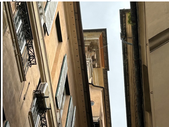
Foto 13 – Risvolto su Piazza del Ferro
