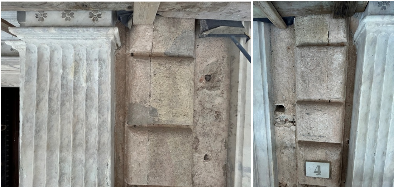
Foto 14 e 15 – Dettagli del portale di ingresso
